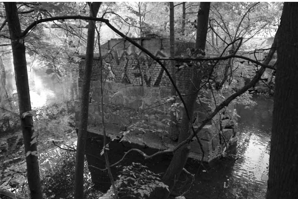
Siste rest av Bentse Brug, papirfabrikken ved Akerselva som produserte papiret Grunnloven er skrevet på.
